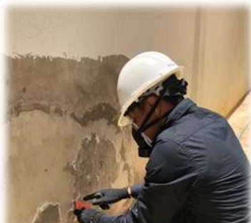
*RETIRO DE ESTUCO AFECTADO EN MUROS EXTERIORES DE LA IPSI.*
